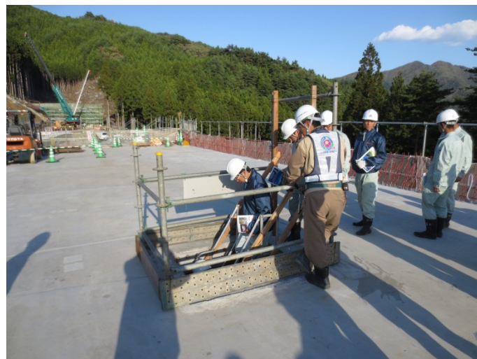
▲現場研修状況
