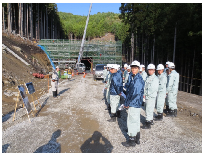
▲現場研修状況
